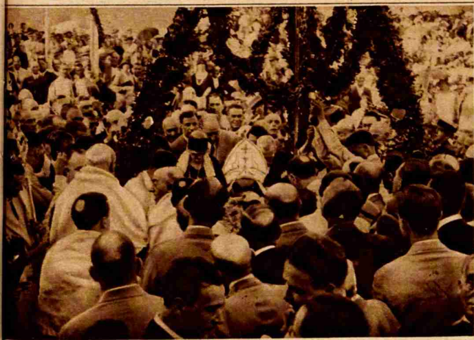
PALMA DE MALLORCA.—Momento de colocar la primera piedra para las obras del Sanatorio Antituberculoso costeado por D. Juan March.
