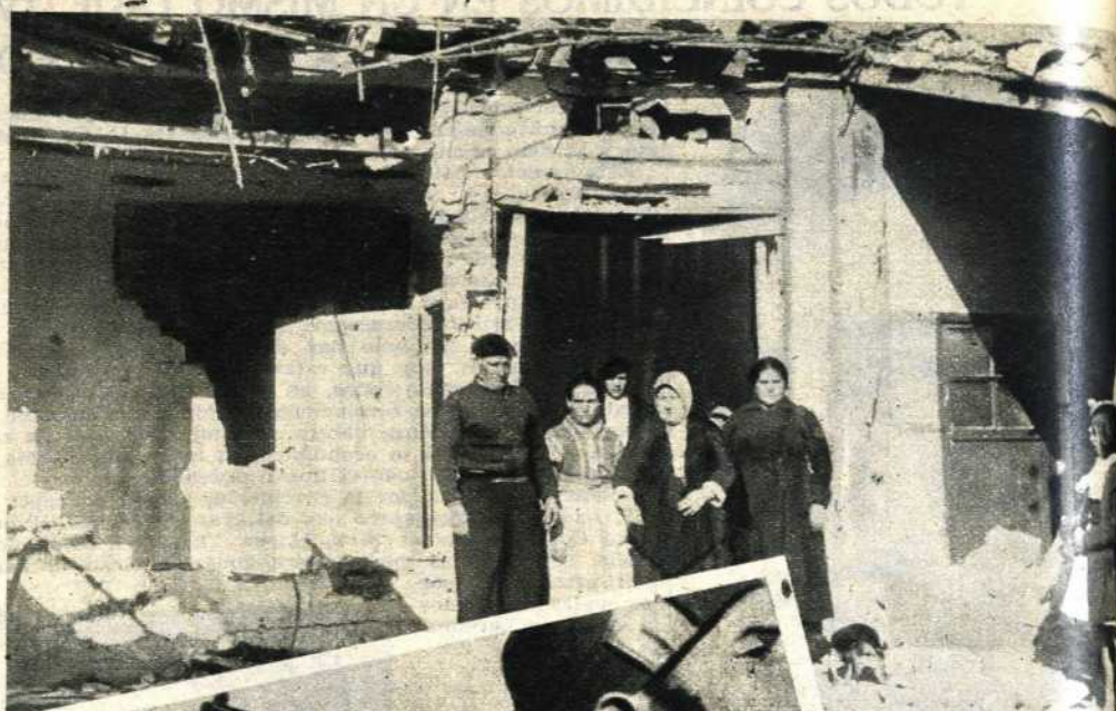
Una humilde casa de un pblecito costero valenciano destruida por el reciente barbardeo faccioso
