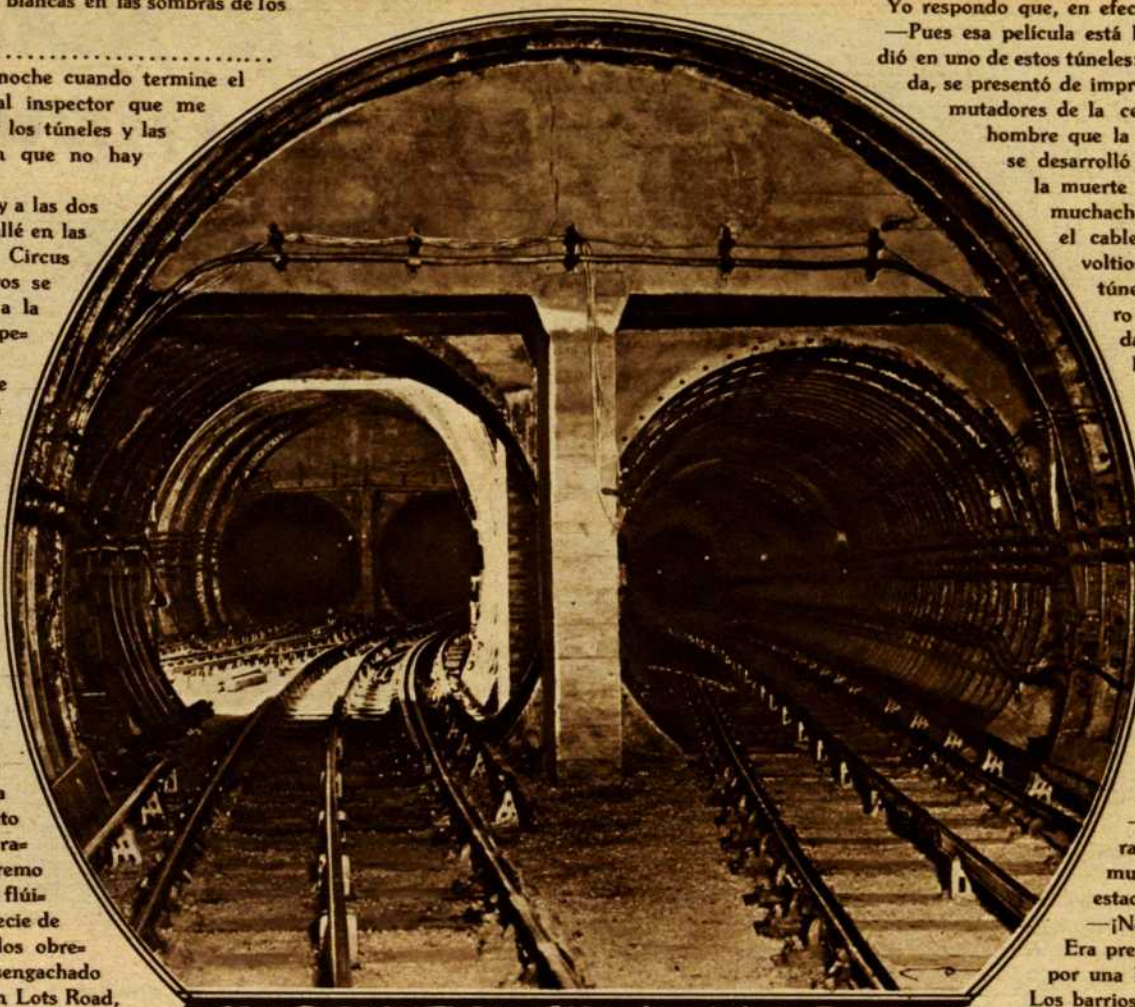
Cruce de túneles en la estación de Candem.
