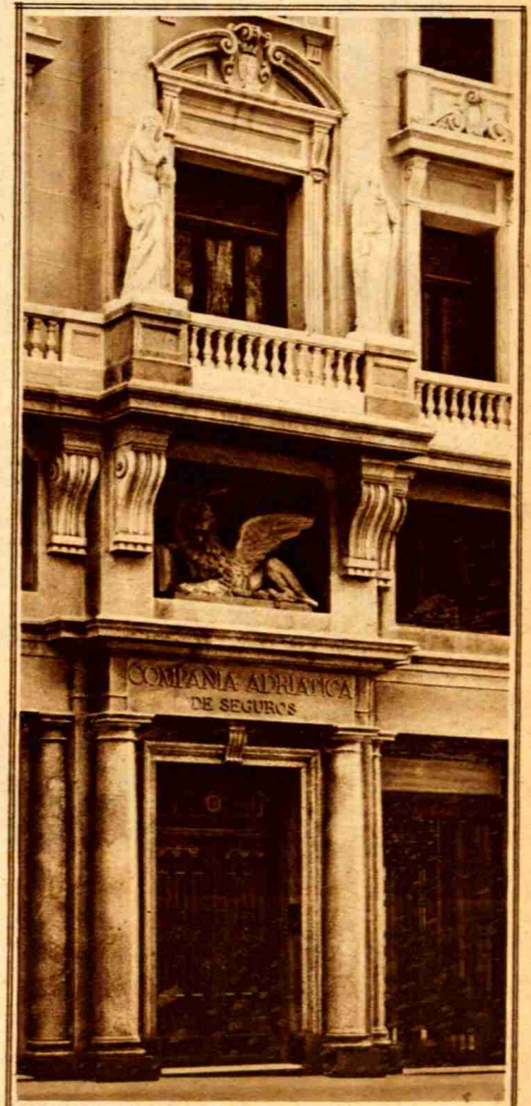
Detalle de la fachada.
