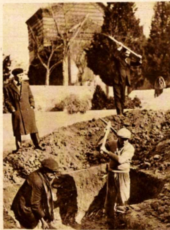
El escultor Barral, presenciando los primeros trabajos en el Cementerio civil del Este.
