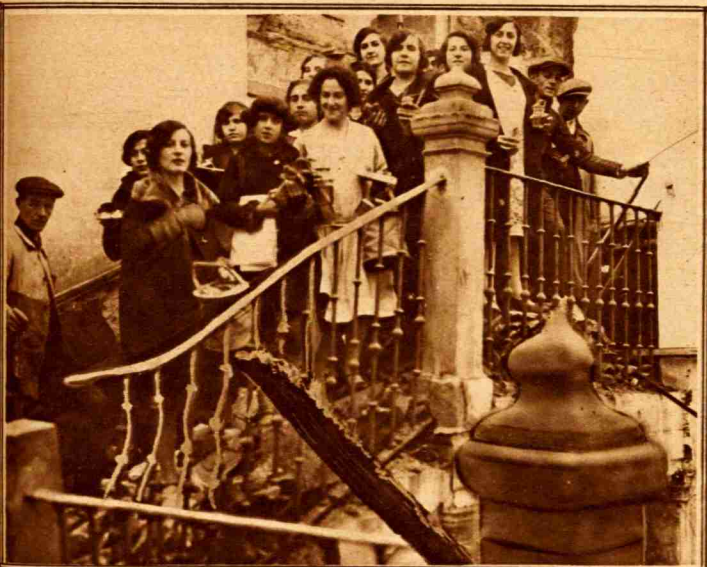
Grupo de alumnas entre los escombros de la Escalera Central del edificio siniestrado, después de apagado el fuego.
