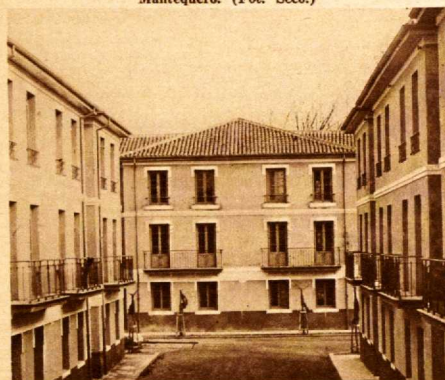
SANTANDER.—Construcción de casas baratas. Una de las calles del Barrio Obrero del Rey, inaugurado recientemente. (Fot. Samot.)
