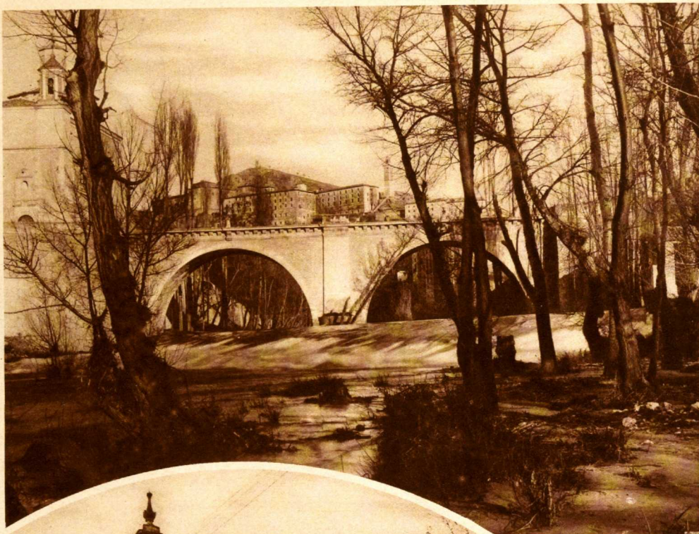
Puente de San Antón, sobre el río Huécar.
