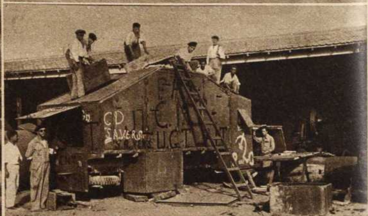
Un taller metalúrgico malagueño donde se construyen numerosos blindajes para camiones, que salen diariamente para reforzar nuestras columnas
