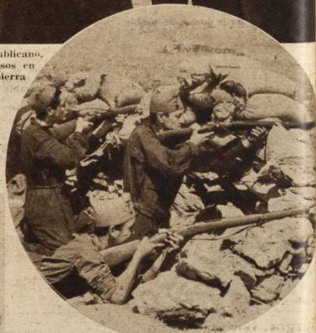
Una avanzadilla situada en la primera línea del sector de Peguerinos (Foto Albero y Segovia)
