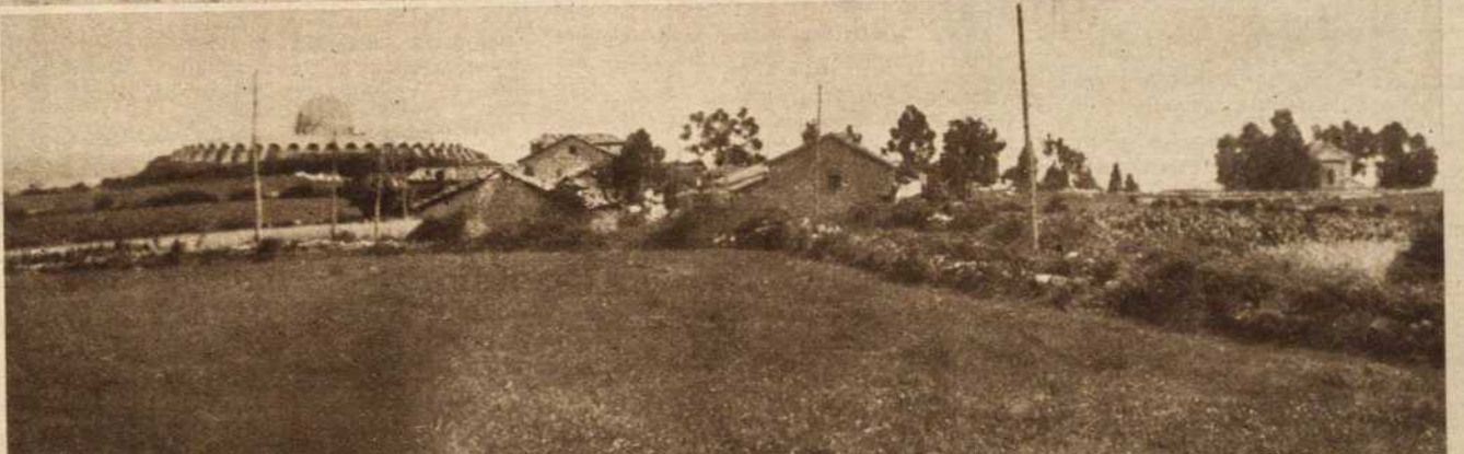
A la izquierda, el depósito de aguas de Oviedo, y a la derecha, escondida entre árboles, la iglesia del Cristó, dos reduc- tos de los rebeldes de Oviedo, que están tan estrechamente cercados, que la fotografía ha sido obtenida a la distancia de trescientos metros (Fotos Morán del Val)
