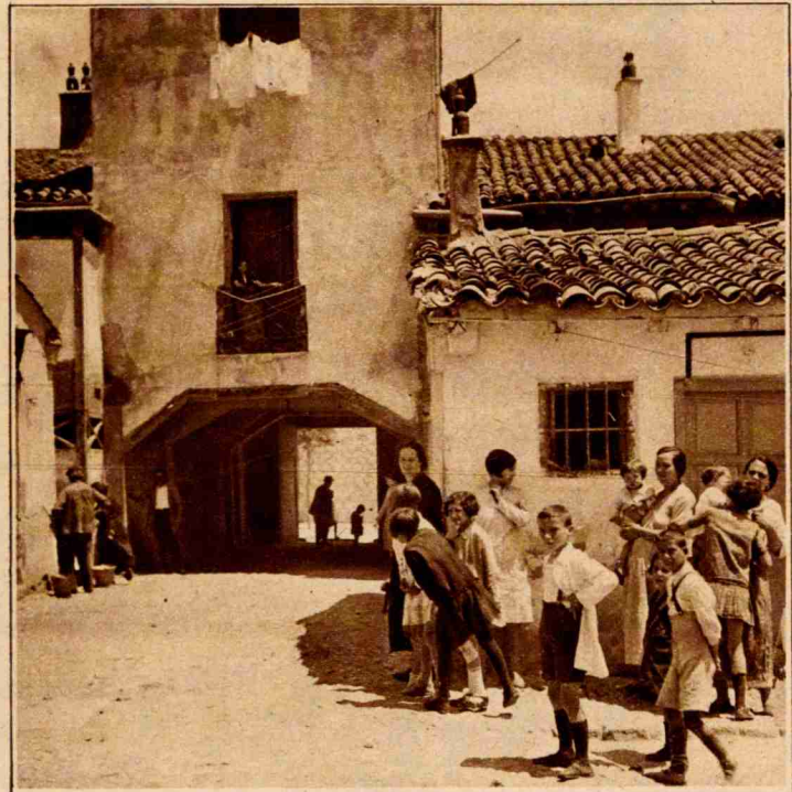
El ancho pasadizo por el que se entra a la casa, con gran portalón al fondo.
