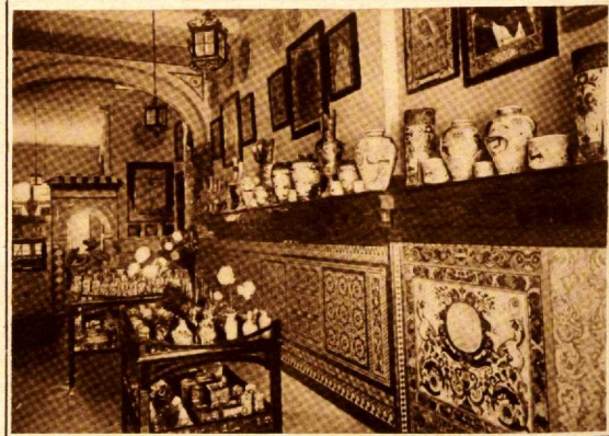
Patío sevillano, obra de la Casa Mensaque.
