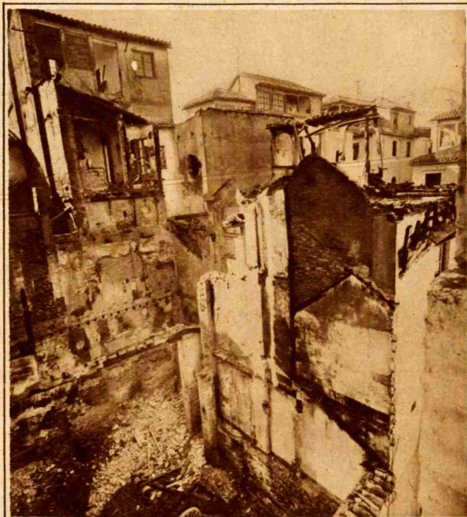
GRANADA.—Estado en que quedó el grupo de casas destruidas por las llamas a consecuencia del incendio de una fábrica de maderas. (Foto Torres Molina.)
