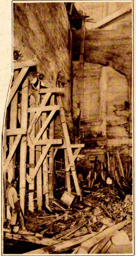
Vaciado y recalzo de cimientos, obra de gran importancia para la consolidación del Teatro Real.
