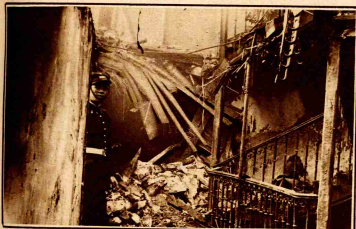
Vista parcial del interior del teatro después del siniestro, que lo destruyó por completo. (Foto Cervera.)
