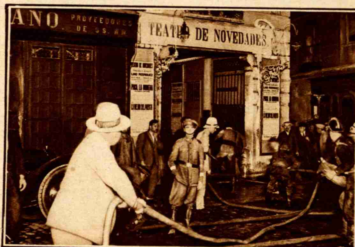
Los bomberos, trabajando en la extinción del incendio, entran con las mangas por la puerta de la fachada principal. (Foto Cervera.)
