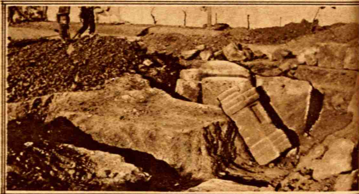
Los restos de lo que fué templo romano, en cuyo total descubrimiento trabaja actualmente el Comisario Regio de Bellas Artes. (Foto Torro)
