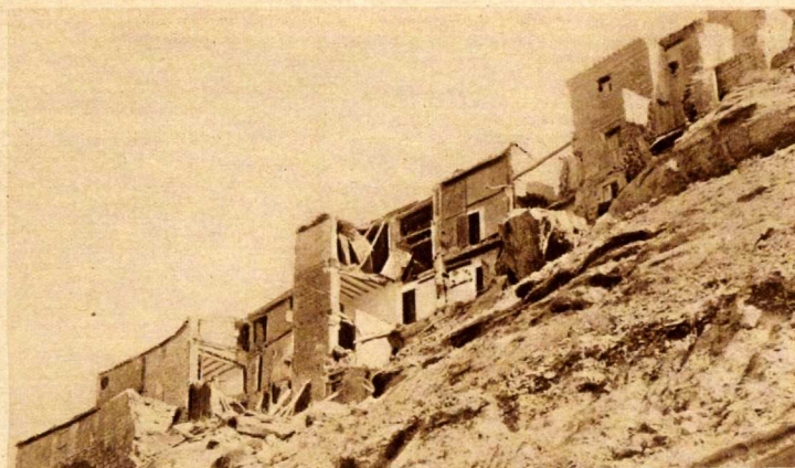
ZARAGOZA.—La catástrofe de Chiprana. Ruinas de las ocho casas hundidas a consecuencia de un desprendimiento de rocas. (Fot. Barrera.)
