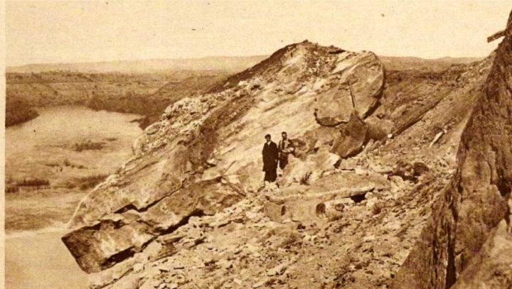
ZARAGOZA.—La catástrofe de Chiprana. La roca que, al desprenderse, produjo el derrumbamiento de ocho casas. (Fot. Barrera.)
