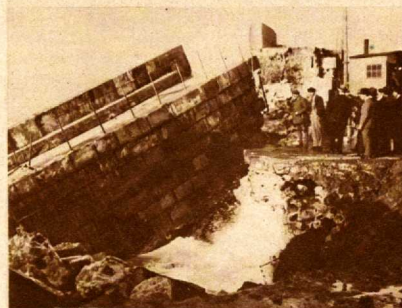
GIJON.—Aspecto del muro de Lequerica, destruido por el oleaje durante el reciente temporal. (Fot. Juárez.)
