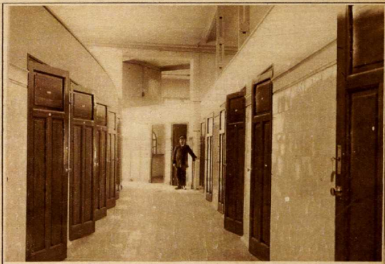
El pasillo de cabinas para baño y ducha.
