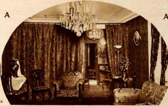
Vista de los suntuosos salones de la gran casa de Modas «MONFORT», inaugurada en la Avenida del Conde de Peñalver, núm. 5, entresuelo.
