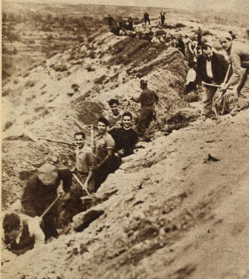
Nuestros obreros voluntarios trabajando afanosamente, en todas las horas que su labor diaria les deja libres, en la construcción de trincheras
