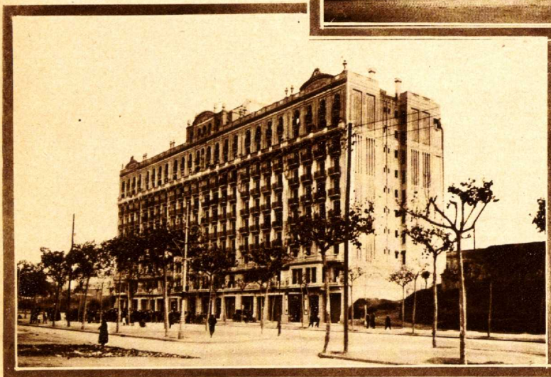
Casa de nueva construcción, al final de la calle de Cortes. Este edificio, que consta de diez plantas, tiene 216 pisos para vecinos.
