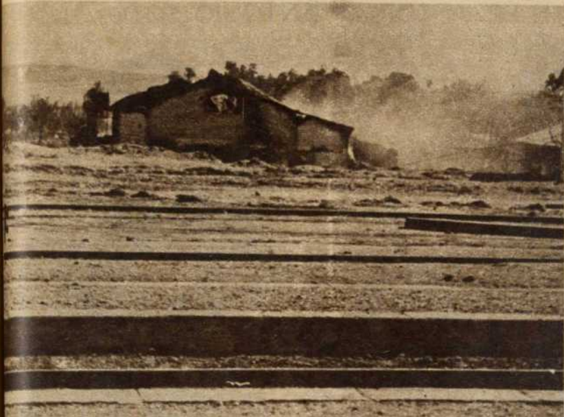
Efectos de la Artillería sobre unas casas inmediatas a la vía férrea. Nuestro avance fué tan rápido que al llegar las fuerzas de Infantería aun perduraba la humareda
