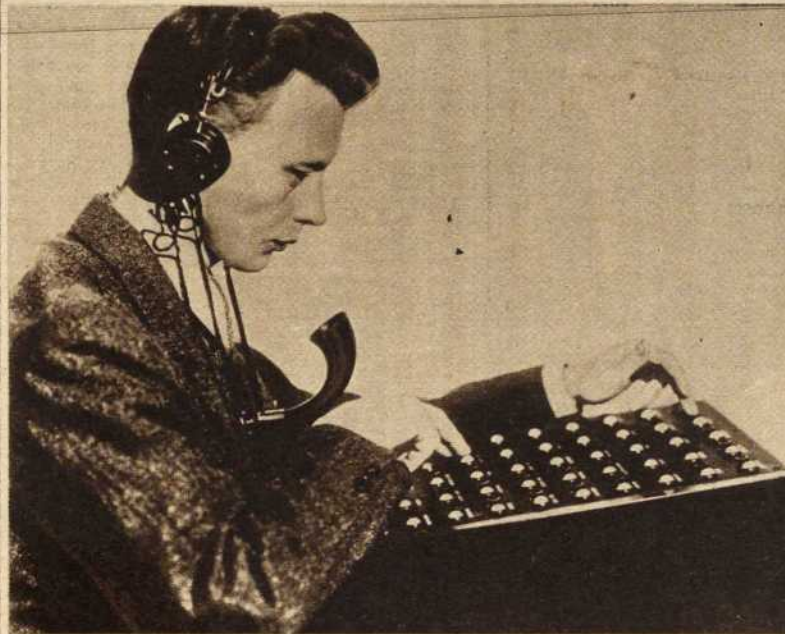
Cuadro de mando de micrófonos construido especialmente para el Congreso de la Convención Nacional Republicana, en Cleveland, que permite unir 54 micrófonos a las redes de emisoras
