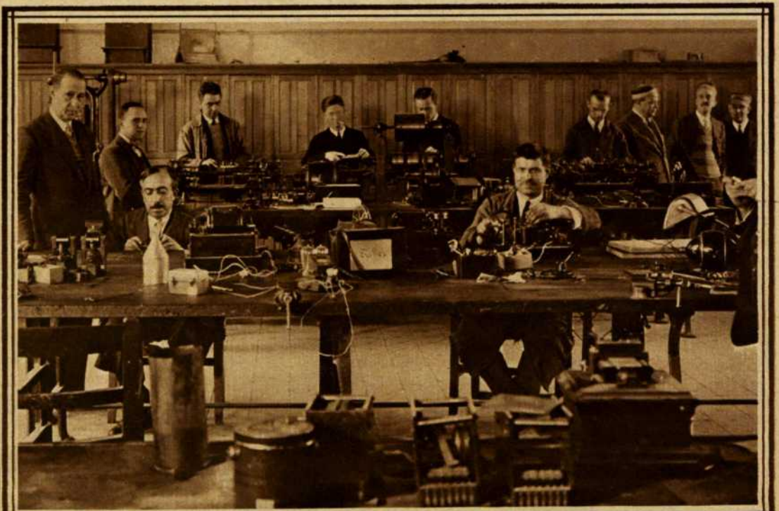
Talleres anejos a la Sala de aparatos.
