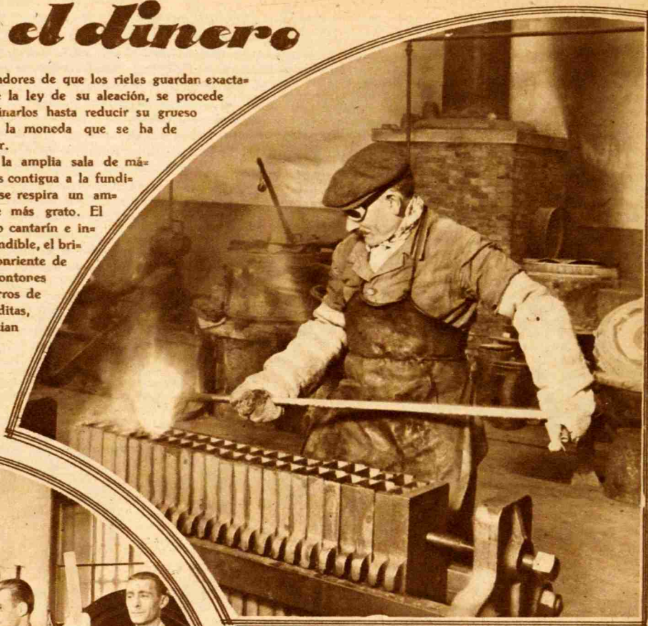
El metal, convertido en caldo, penetra en los moldes.
