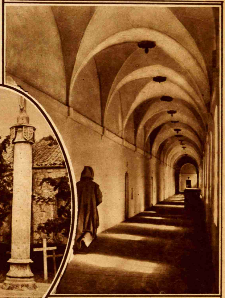
Uno de los blancos corredores del claustro, en el que se ven las puertas y postigos de las celdas.
