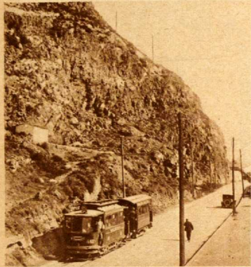
BARCELONA.—Trozo de la montaña de Montjuich del que se desprenden enormes piedras, que caen sobre la carretera de Casa Antúnez. (Fot. Badosa.)
