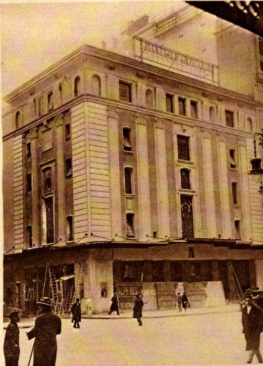
La fachada del suntuoso teatro Avenida.
