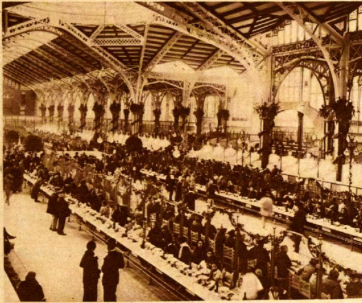
VALENCIA.—Aspecto del nuevo Mercado Central durante la paella servida a los pobres para festejar la inauguración del soberbio edificio. (Fot. Desfilis-Barberá.)
