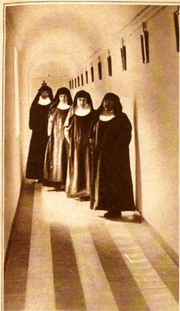
El largo corredor, de aspecto conventual, que une el edificio con la capilla.
