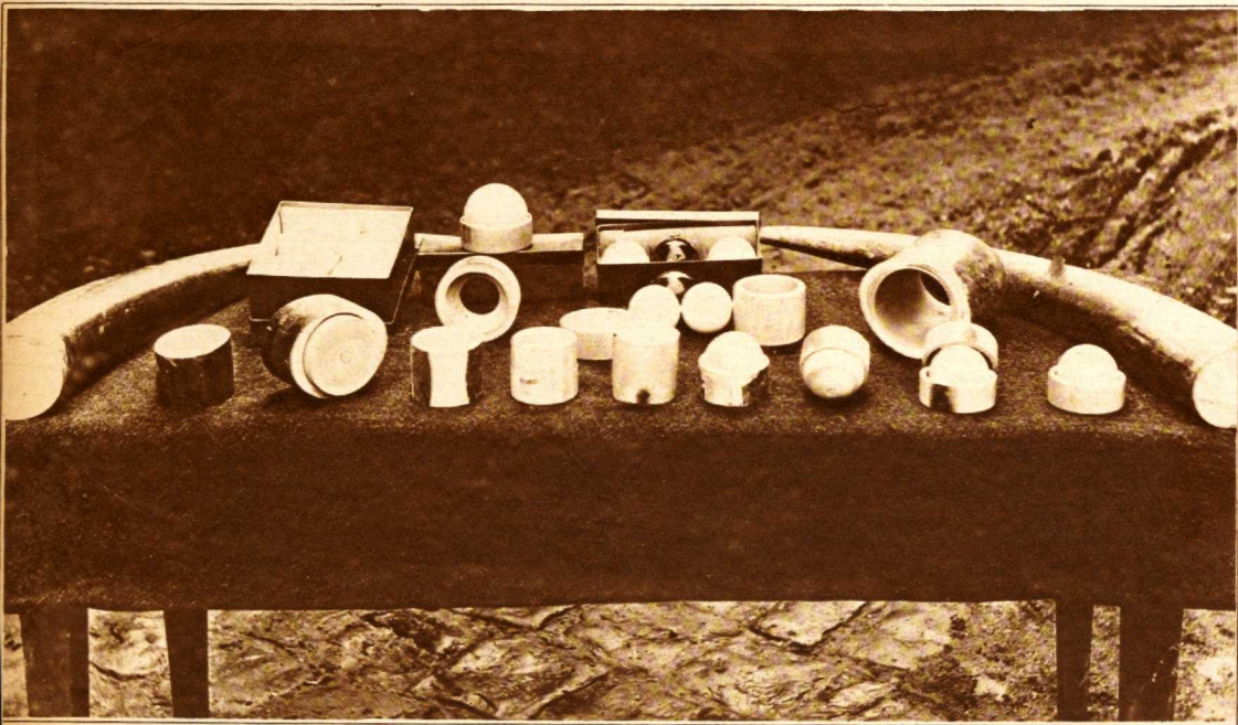
Las diversas fases por que pasa un colmillo hasta que se obtienen las bolas de billar.
