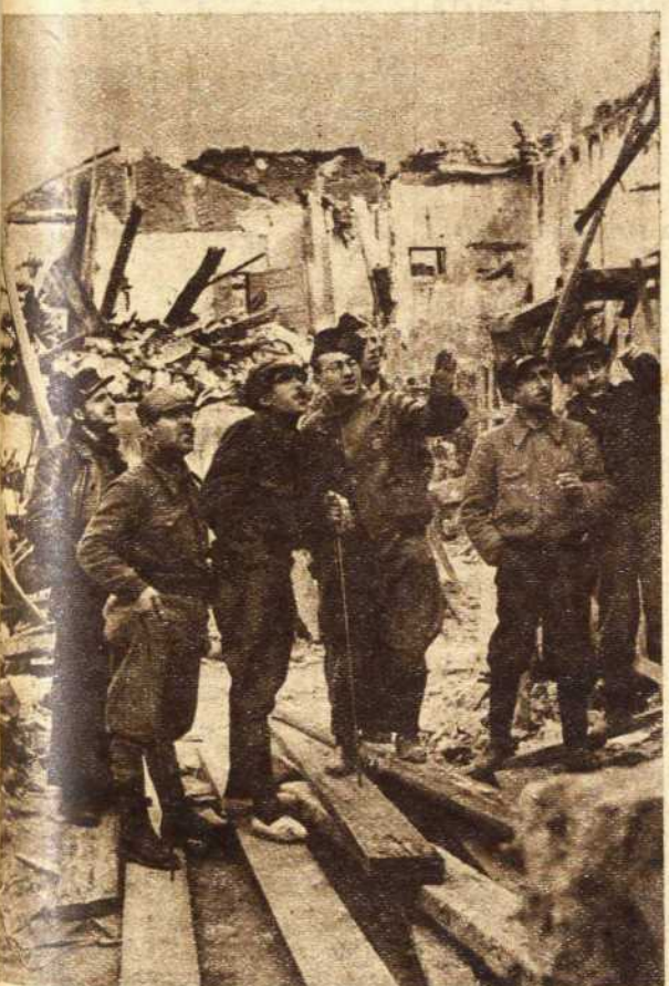
¡Jefes y oficiales de la Brigada recorren nuestras nuevas posiciones en el barrio recién conquistado. Estas casas destruidas y carcomidas por la metralla no volverán a ser de ellos. Nuestros batallones de fortificación han puesto su firma de zanjas y de parapetos al pie de la nueva conquista del Ejército del pueblo
